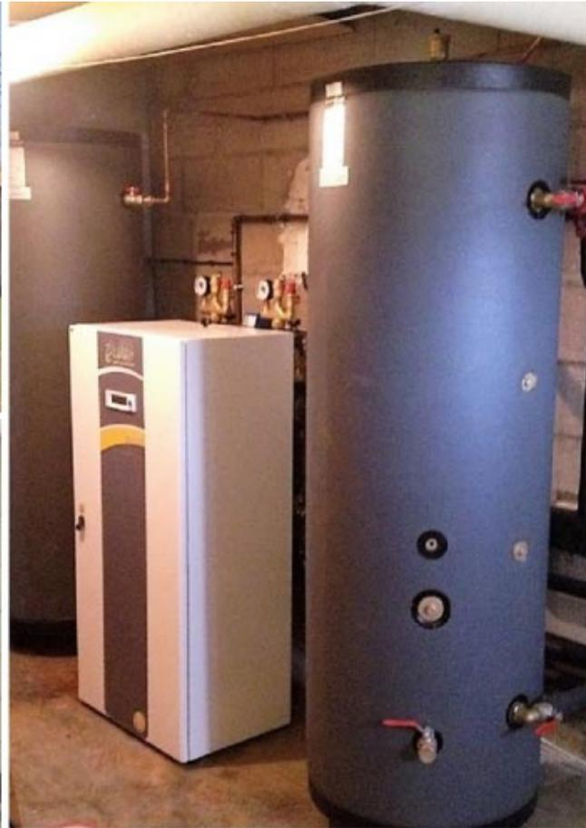
*Géothermie sur forage verticale, env. 160m<sup>2</sup> chauffés. Production d'eau chaude sanitaire. Reprise de l'ancien réseau de radiateurs sans modifications.*
