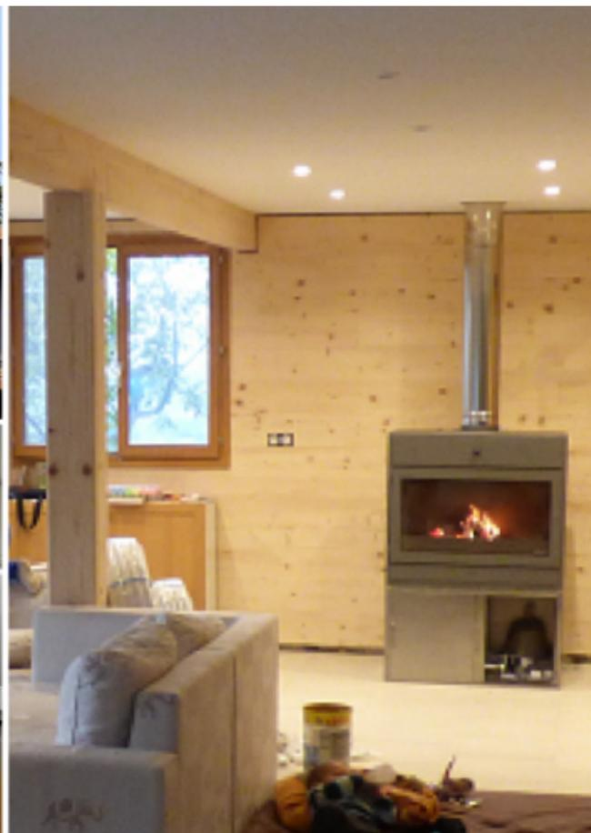
*Poêle à bûche hydraulique DDG installé à l'étage, comme seul chauffage. Environ 250 m<sup>2</sup>, isolation importante type BBC, conso annuelle env. 10 stère. Le poêle de l'étage chauffe le RDC.*
