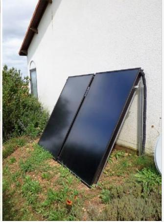
Installation d'une géothermie horizontale couplée sur un capteur solaire thermique pour l'eau chaude. Maison de 140m² de 1980.
