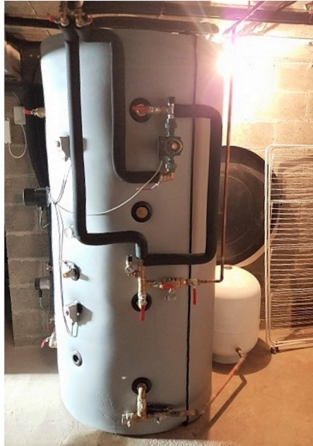
*Chauffage au bois à la frontière entre la Vienne (86) l'Indre (36) Un Poêle / Insert connecté au chauffage, avec un ballon tampon de 1000 litres. Le confort d'un chauffage central avec programmation avec uniquement un point de chauffe dans le salon. Aucune modification sur les radiateurs existants.*
